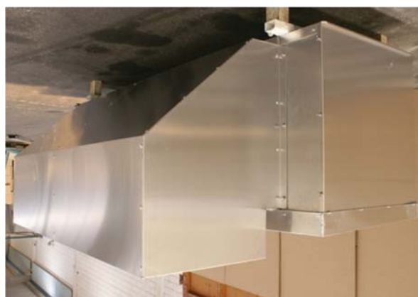
Evaporador com pleno de aspiração e adaptador de condutas Cooler with suction plenum and air sock adapter
