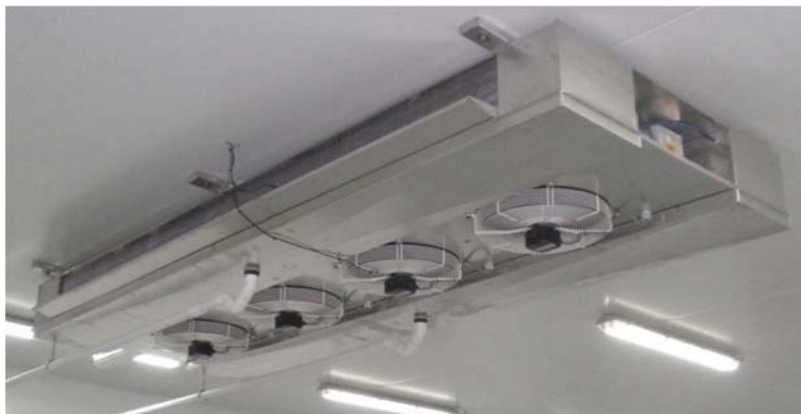
Evaporador CB CB cooler
