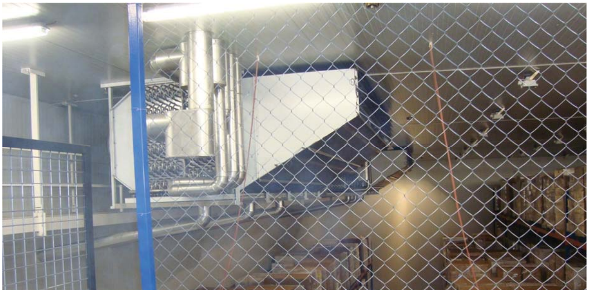
Evaporador BSUIT especial em aço inox Special stainless steel BSUIT
